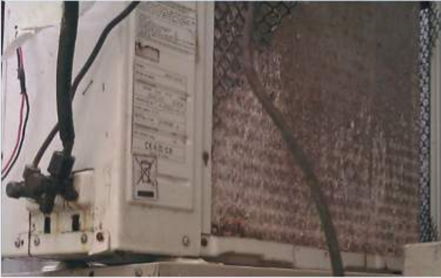
Corroded condenser fins
